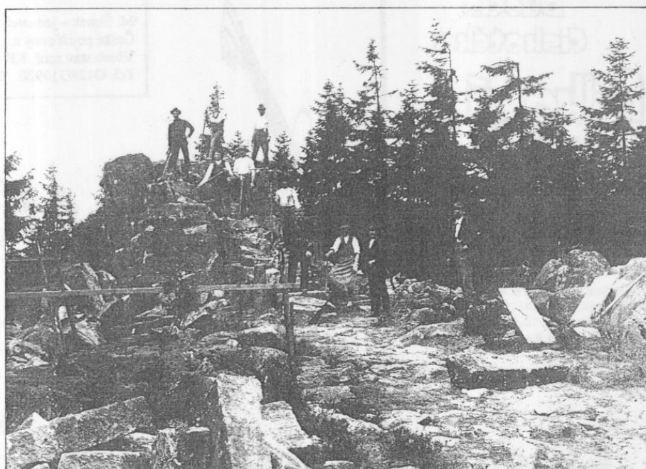
Kameníci na vrcholu Černé Studnice při zahájení prací na stavbě černostudniční rozhledny a s tím spojeným rozštípáním jednoho z vrcholových skalisek v místě budoucí rozhledny (1904).
